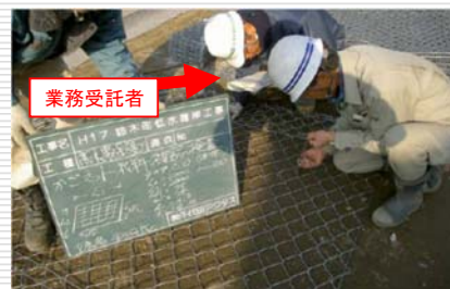
（河川護岸用かごマットの材料確認）
