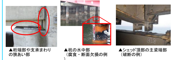
▲桁端部や支承まわりの狭あい部
