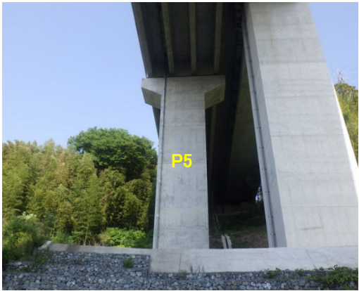
対象橋脚（P5 橋脚）
