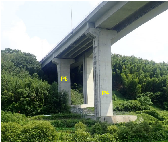
はやまおおし 葉山大橋状況写真
