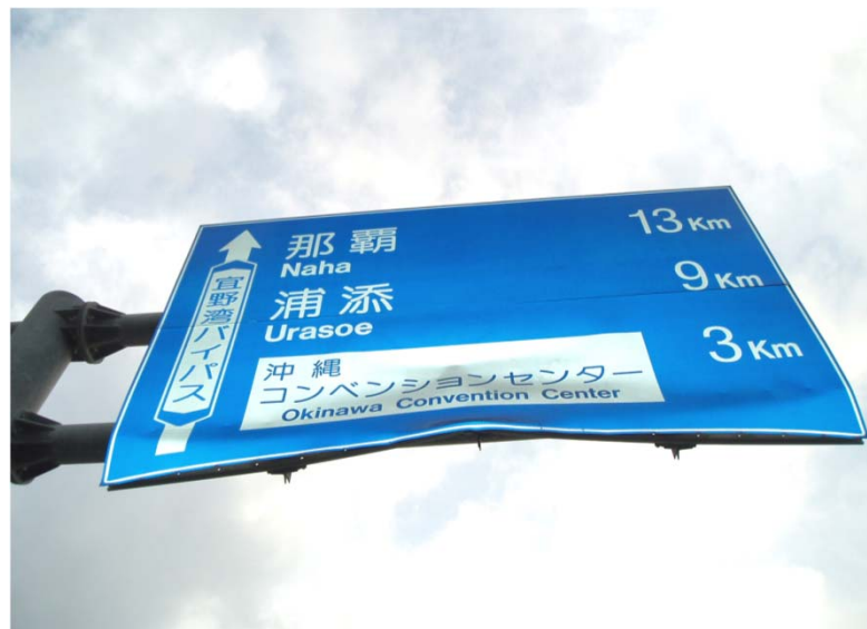
異常変形 (車両衝突)
